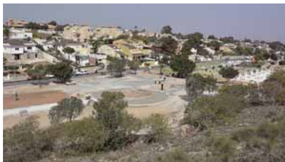
NY PARK: Arbeidsledige bygger ny aktivitetspark i Torreveija.
