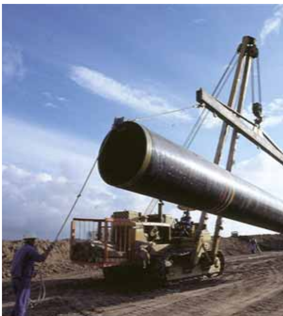
NYTT GASSNETT: Det skal bygges et nytt gassnett i Benidorm og det kan føre til at La Nucia, Altea, Alfaz del Pi og Polop kan få innlagt gass innen to år.
