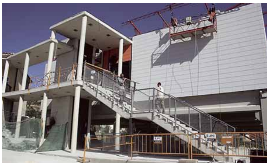
FERDIG: Den Norske Skolens nybygg er ferdig. Skolen mangler bare fylkesmannens godkjenning før bygget kan tas i bruk.
