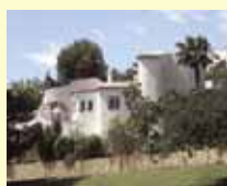
Altea La Vieja: Sjarmerende bolig nær golfbanen Don Cays. Flott panoramautsikt over havet. Boffate 120 kvm. og tomt på 1.160 kvm. Svømmebasseng som er oppv. av solenergi. Hage i Middehavstil. Romsig garasje og lagerrom. Pris: 395.000 €
