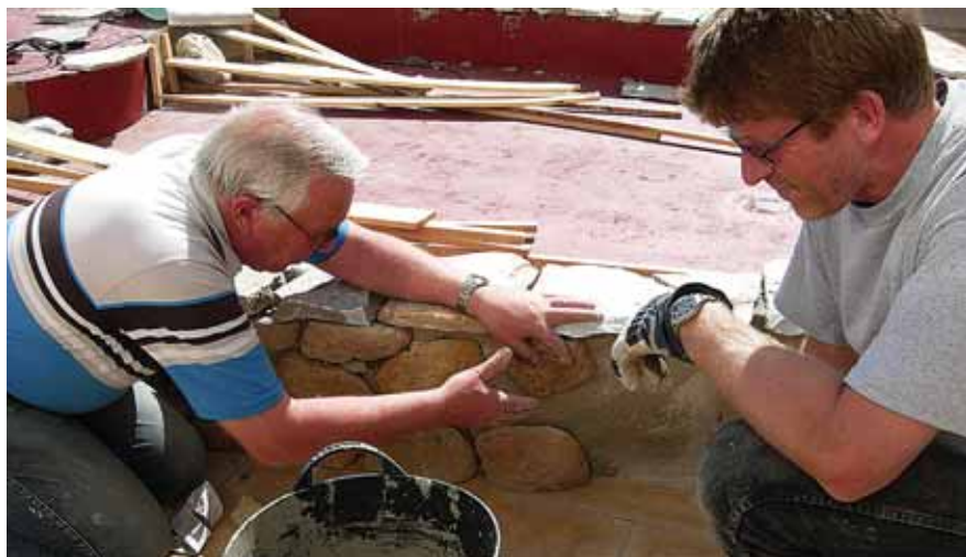
MYE ARBEID: Roar Bergill og Terje Øyen har begge lagt ned mye arbeid med den nye fontenen – sammen med flere andre.
