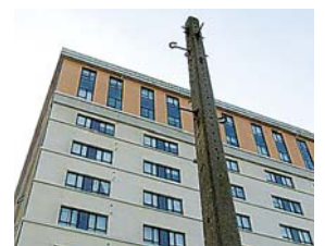
REPARASJONSARBEID: 47-åringen falt ned fra en telefonstolpe da han var i ferd med å reparere en kabel.
