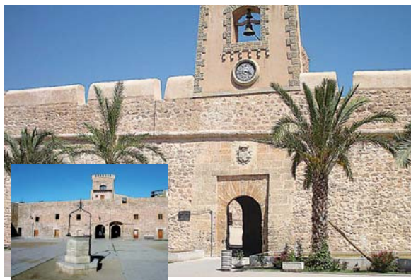
KULTURSENTER: Sentrum av Santa Pola domineres av festningen el Castillo-Fortaleza, som ble bygget som et forsvarsverk mot pirater i 1558. I senere tid har forsvarsverket blitt omgjort til kultursenter.
