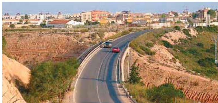
FARLIG VEI: Beboere i Cabo Roig området ønsker seg gangvei og har underskrevet en erklæring som er oversendt rådhuset i Orihuela.
