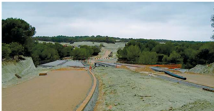
PAU21: Det er allerede gjort uopprettelige skader på miljøet i PAU 21, sier José Maria. Prosjektet ble ikke stoppet før etter flere måneder med utgraving og bygging.
