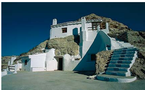
ENØK: Over store deler av spania finner vi slike hus, halvt inne i fjellet. Mest utbredt er denne byggemåten i Granada, hvor fortsatt mange bor slik i disse tradisjonelle men svært så energieffektive husene.
