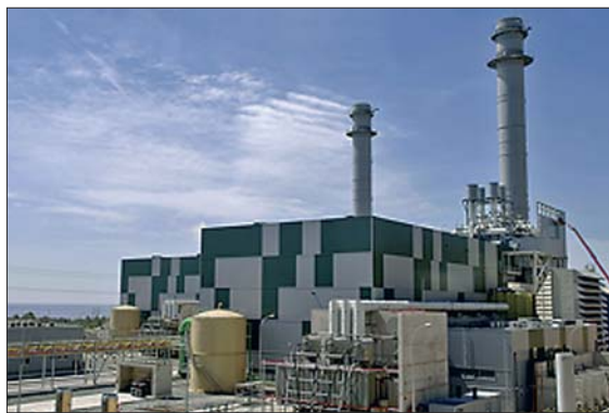
TARRAGONA: Bildet viser et av Gas Natural sine gas-kraftverk i drift utenfor Tarragona i Katalonia.
