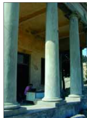
Vaktmannen på borgen har et standsmessig kontor.
