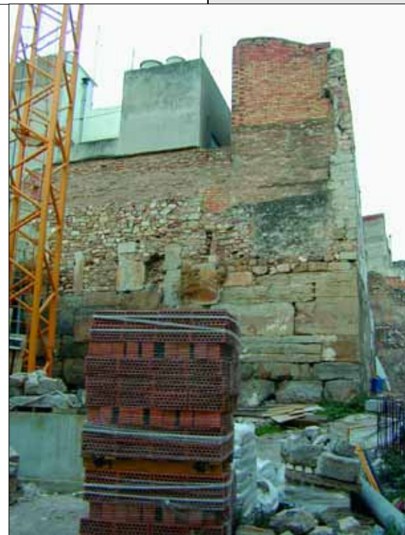
I dag er Dianas tempel en byggeplass godt skjult bak tildekkede gjerder.
