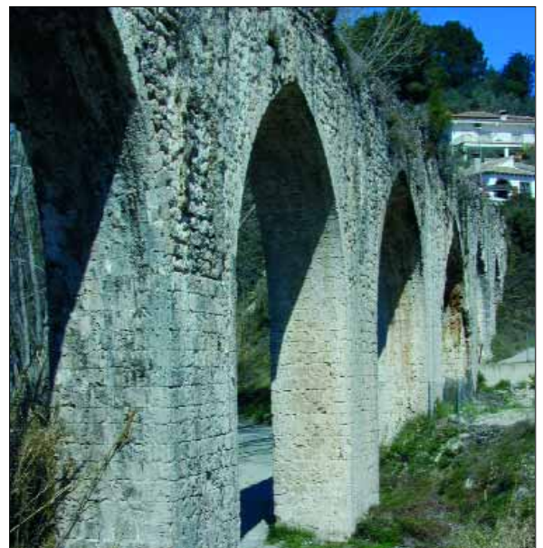
Imponerende romerske vannledninger utenfor landsbyen Alboi.
