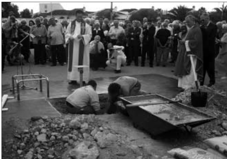
STEN FOR STEN: Grunnsteinen blir lagt ned av to spanske arbeidere ansatt hos entreprenøren som står for oppføringen av kirkebygget.
