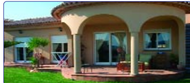
Ny villa - Miramar 450 m 2 pent opparbeidet tomt, solfylt, utsikt, 110 m 2 , 3 sov, 2 bad, stue med peis, overb. terrasse, solarium, carport, barbeque, sentralfyr, høy standard. 348.000€
