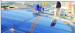
Bildet viser solpanel vi har montert på tak (På Bårums Recidencia).
