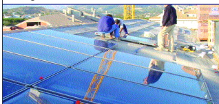
Bildet viser solpanel vi har montert på tak (På Bærum's Recidencia).
