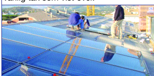
Bildet viser solpanel vi har montert på tak (På Bærum's Recidencia).
