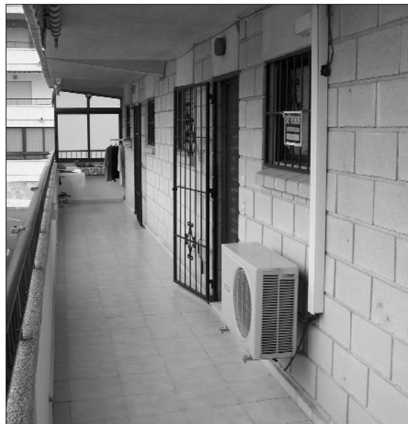
SAKENS KJERNE: Air Conditioner-anlegg til besvær.
