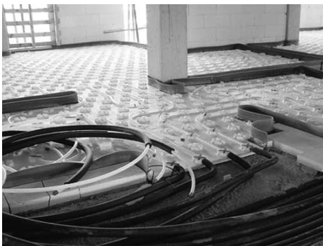
Bildet viser kvalitetskomponenter vi benytter, samt gulvvarme under installering.
