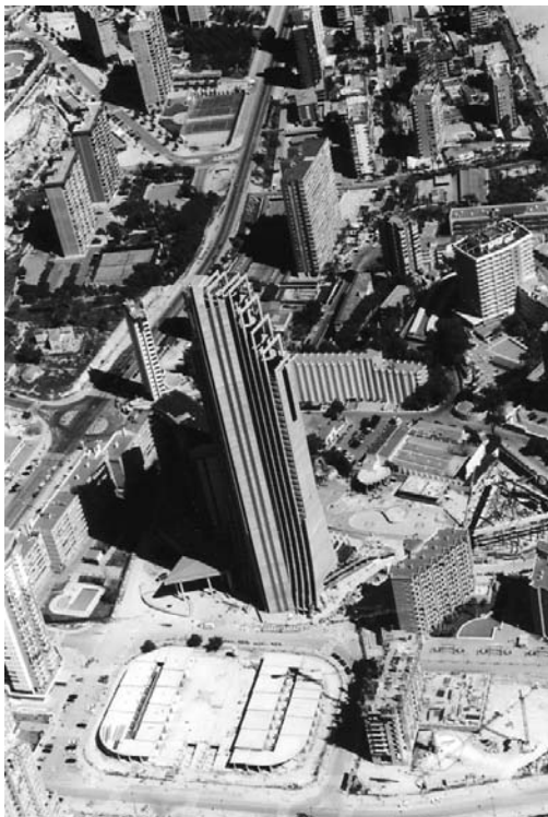
Enda ett nytt hotell under konstruksjon i Benidorm
