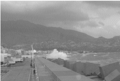
Deler av veien langs promenaden ble stengt og store mengder drvgods havnet på land og på parkeringsplassen
