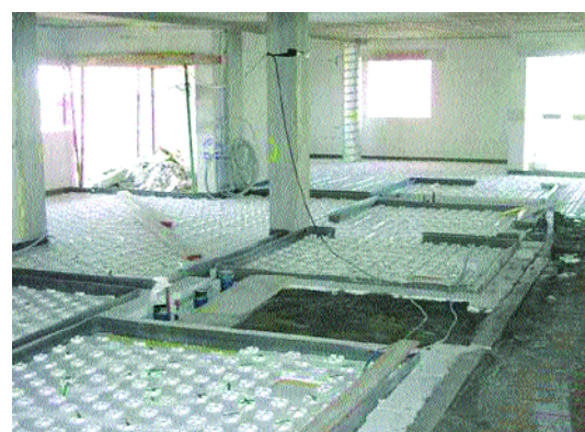
System for distribusjon av gulvvarme
